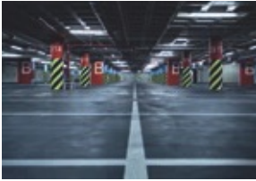
underground parking garage el garaje subterráneo
