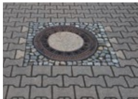
manhole cover la tapa de alcantarilla
