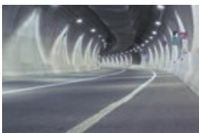
tunnel el túnel
