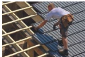
roofer el techador
