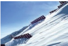
avalanche protection la protección contra aludes
